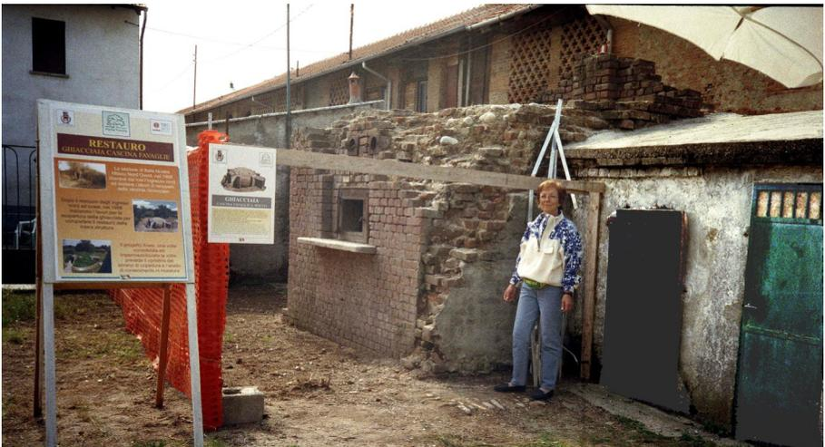
Il Cantiere per il recupero dell'antico forno. Il progetto è stato rivolto a salvaguardare e mantenere l'integrità dell'originale struttura esistente, provvedendo, in alternativa al primitivo portico ormai non fattibile per le attuali esigenze di passaggio, un piccolo voltino in mattoni per riparare il fronte dalle intemperie.
