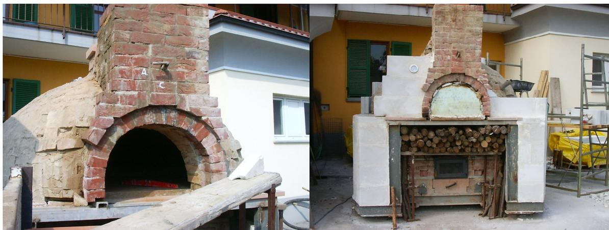
Prima versione del frontale del forno con la cupola di cottura, si vede la leva di comando della valvola a farfalla di regolazione uscita calore con condotto di uscita calore inserito all'interno della bocca forno dopo la porta di chiusura, ancora mancante.
