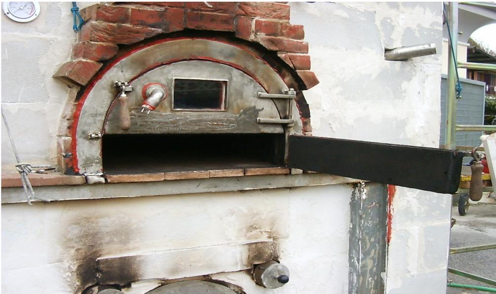
**Particolare porta in due settori di apertura e chiusura del forno, dove la parte rettangolare bassa serve per infornare senza avere il riverbero del calore del forno sulla faccia e per il controllo della cottura del pane.
