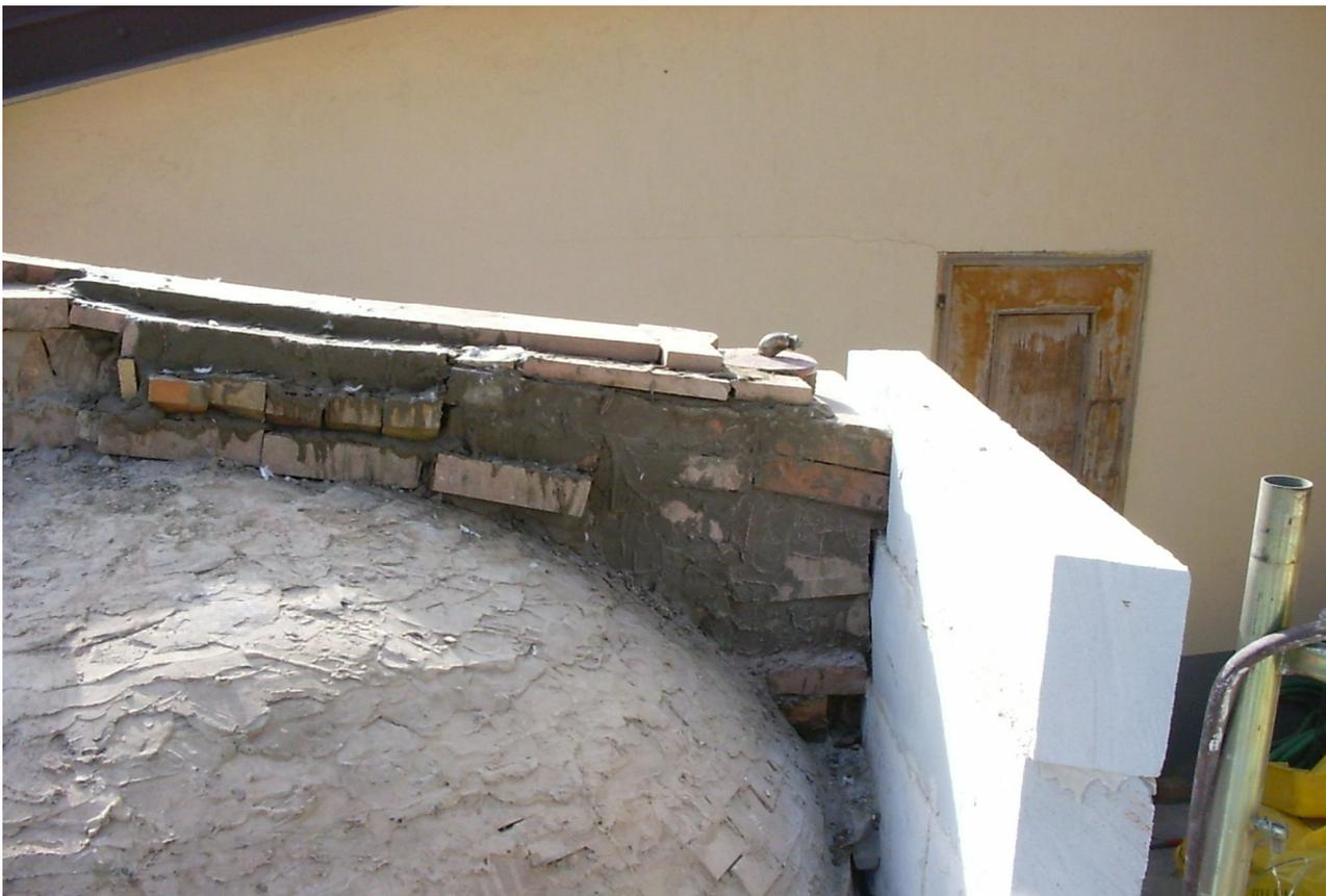
**In questa foto il muro perimetrale posteriore e già alto quasi al termine (manca un mattone), si vede il terminale del tubo diametro cm 16 d'acciaio con il coperchio posizionato sopra al T di acciaio di collegamento che potrebbe servire da ispezione e controllo sia del condotto che della valvola a farfalla inserita sopra l'uscita dalla Camera di Combustione, con raccordo di sfiato da 1/2"**
