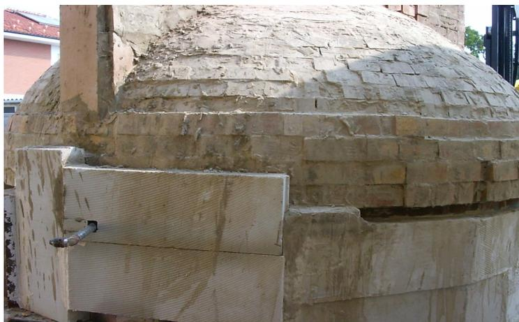
Nei primi 4 giri della cupola ho usato del refrattario con 44% di allumina che avevo in giacenza da moltissimo tempo dai quali ho ricavato, tagliando 12 cm della parte superiore 8 mattoni con i fori per l'accesso dell'aria primaria proveniente dall'esterno alla griglia in ghisa del focolare attraverso appunto i fori dei 4 mattoni per parte del fondo della camera di combustione:
