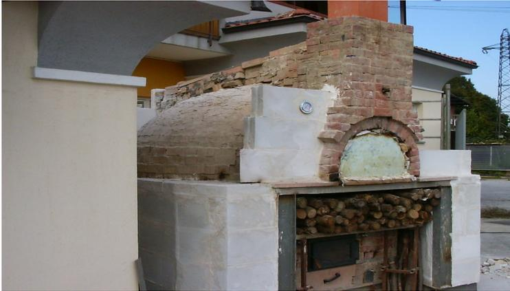
**Stesso stato avanzamento lavori visto dal lato sinistro, dove si vede la cupola finita, la parte del camino rivestito in mattoni pieni, la copertura del tubo di scarico della camera di combustione e la chiusura provvisoria della bocca del forno per la prova con l'accensione del forno atta a verificare il funzionamento del termometro e le valvole a farfalla, ed il tempo di riscaldamento necessario dopo la prima evaporazione dell'umidità accumulata dai muri.**
