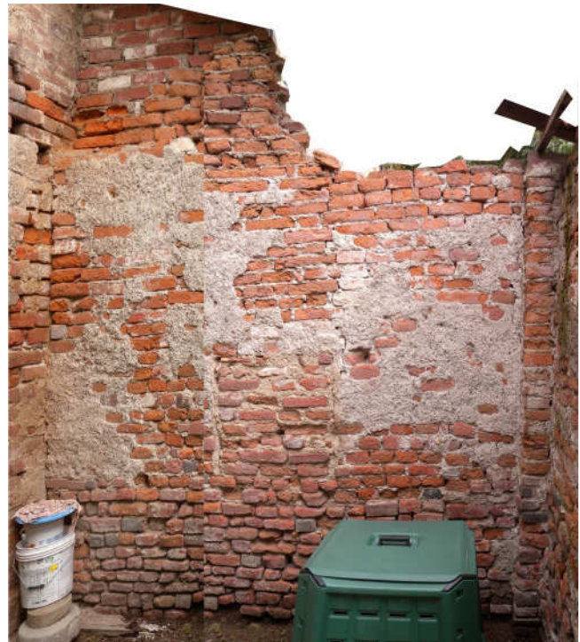
Parete Nord con il vano della porta di accesso. Parete Est, con parte della muratura che reggeva la falda del tetto.
