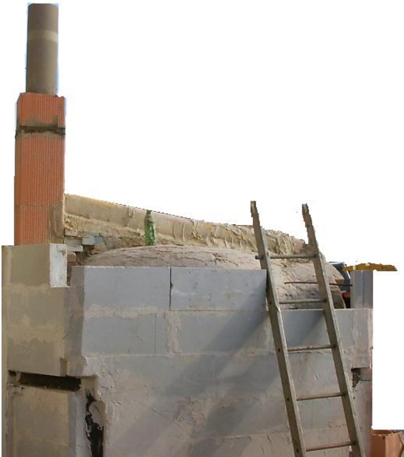
Stessa vista dal lato sinistro del forno in costruzione.
